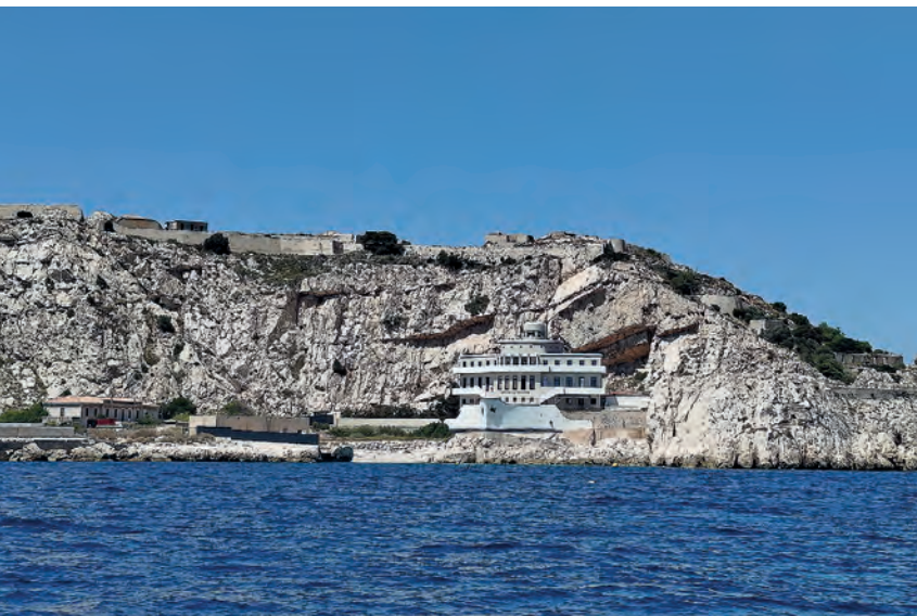
Curioso diseño de la estación de los prácticos del puerto de Marsella-Fos, situada en la isla de Ratonneau, en el archipiélago de Frioul.
