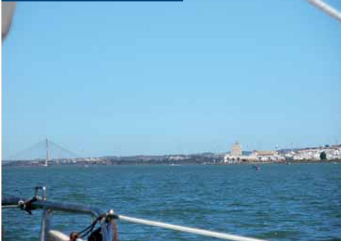
Entrada en el Guadiana, Huelva
